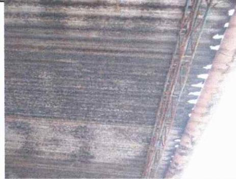
Foto 2: Se observa el deterioro de las costaneras del techo del módulo 1 establecimiento.
