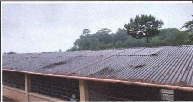
Foto1: Se observa el deterioro del techo del módulo 1 del establecimiento.
