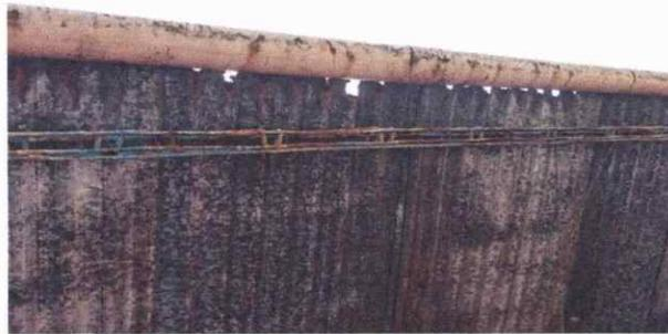
Foto 3: Deterioro de canales del techo correspondiente al módulo 1.
