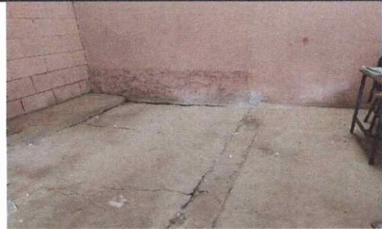
Foto 4: Agrietamiento del piso del aula 4 del módulo 1.
